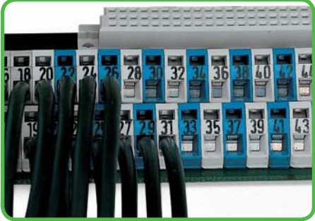
Hintereinander angeordnete Klemmenleisten sparen Platz – um das halbe Rastermaß versetzt angeordnet erleichtert die nachträgliche Verdrahtung der vorderen Reihe.
