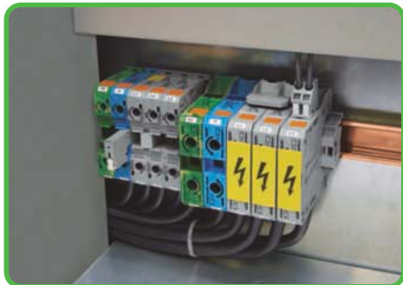
Durch die seitliche Verdrähtung lassen sich auch eingeschränkt biegsame Leiter großen Querschnitts gut anschließen.
