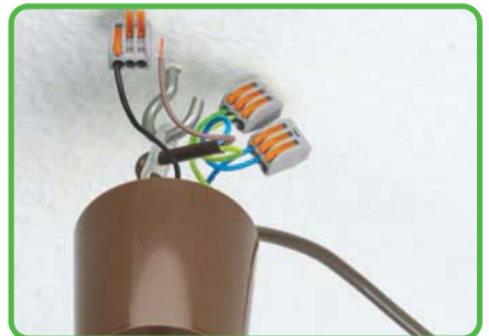
Anschluss von Leuchten mit feindrätiger Weiterleitung
