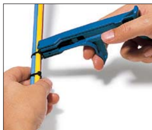
Werkzeug ansetzen, Kabelbinder spannen.
