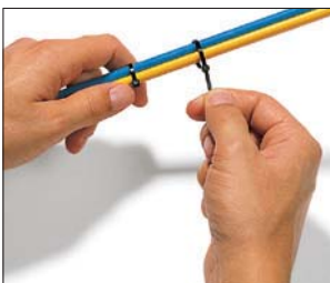
Kabelbinder von Hand vorbündeln.
